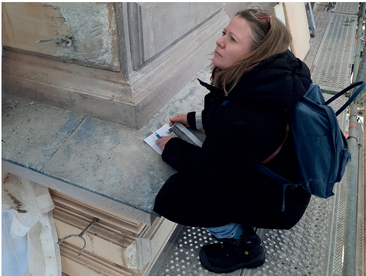
Korjausrakentamisen asiantuntija Annika Korhonen tutkii kaupungintalon julkisivun värikerroksia. Kuva: Kirsi Toivonen.
